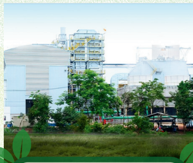
โรงไฟฟ้าพลังงานสะอาด ศรีเชียงใหม่
