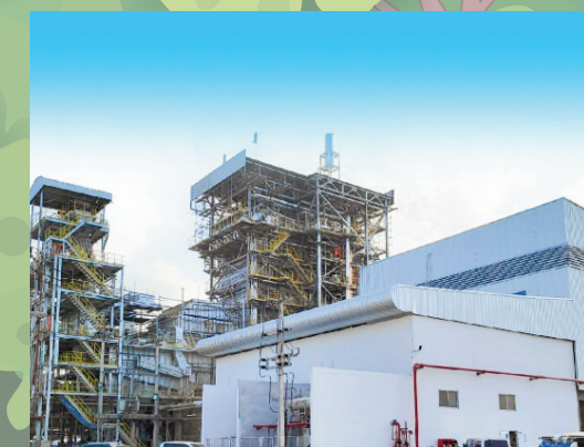
โรงไฟฟ้าพลังงานสะอาดคลองขลุง
