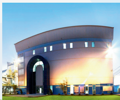
โรงไฟฟ้าพลังงานสะอาดบ้านบึง
